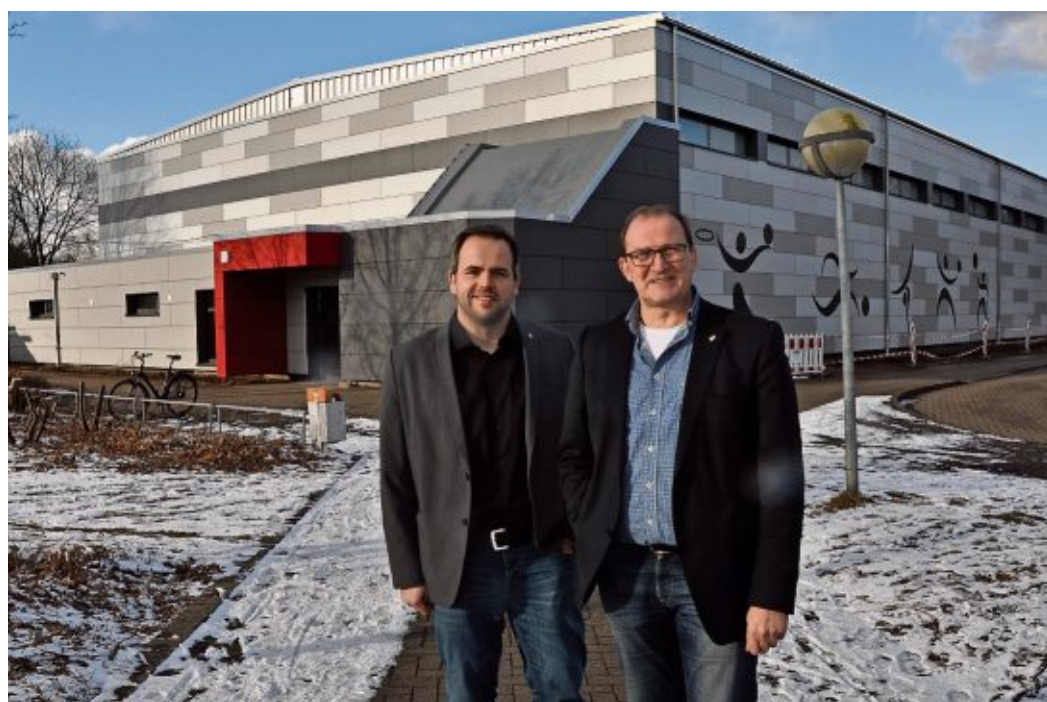
Bürgermeister Axel Renken und Geschäftsbereichsleiter Marcel van der Pütten strahlten mit der winterlichen Sonne und die Wette. Denn am Freitag kann die sanierte Turnhalle am Brilliter Weg auch offiziell wieder ihrer Bestimmung übergeben werden. Fotos: Schmidt
