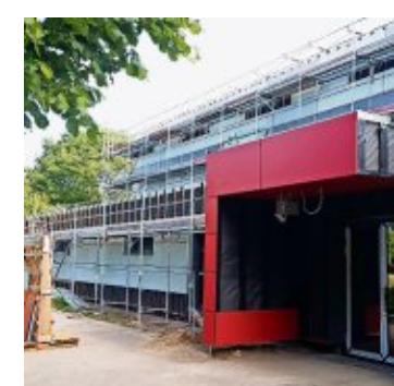
Während der Bauphase...
