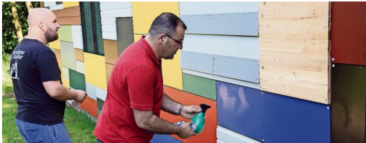
In der vergangenen Woche standen letzte Restarbeiten an der Fassade an, bevor das Projekt mit einem gemeinsamen Grillen abgeschlossen wurde.
