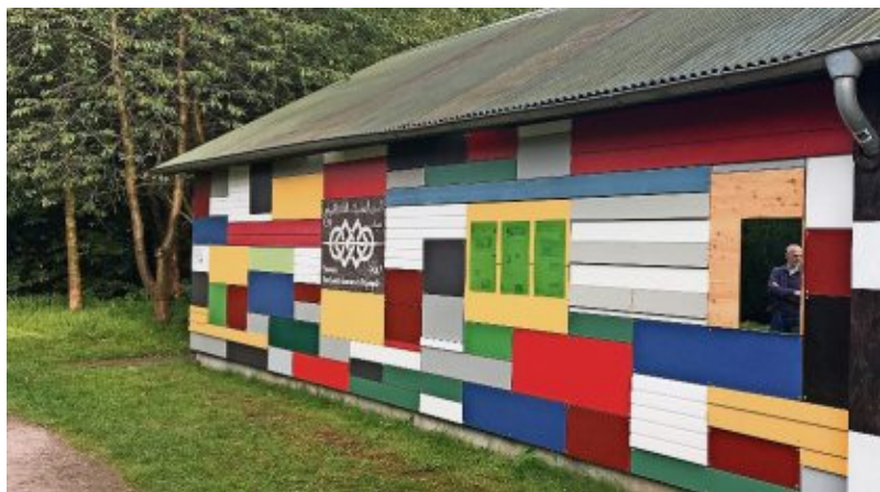
Aus „Abfallmaterialien“ aus der Bauwirtschaft wurde die Fassade der Themenhütte als Patchwork-Fassade neu gestaltet. Fotos: C. Borgardt
