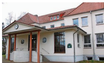
Soll ab dem nächsten Monat umgebaut werden: die ehemalige Schule in Bevern. Fotos: Klöfkom
