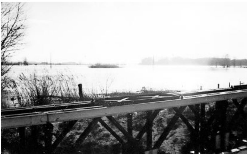
Von der Ostebrücke in Sandbostel geht der Blick auf die unter Wasser gesetzten Wiesen.
