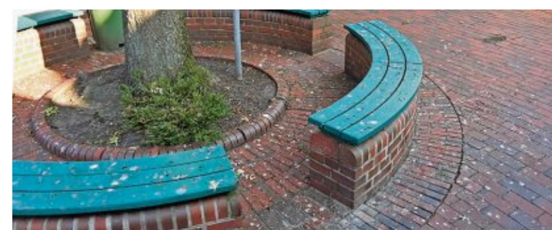
Die Bänke in der Fußgängerzone sind voller Taubenkot. Foto: Höhn
